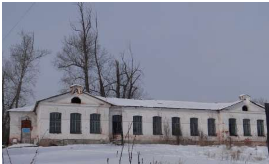
Рис. 1. Одноэтажное каменное здание, принадлежащее Иркутской сельскохозяйственной школе. Фото авторов. Февраль 2023
