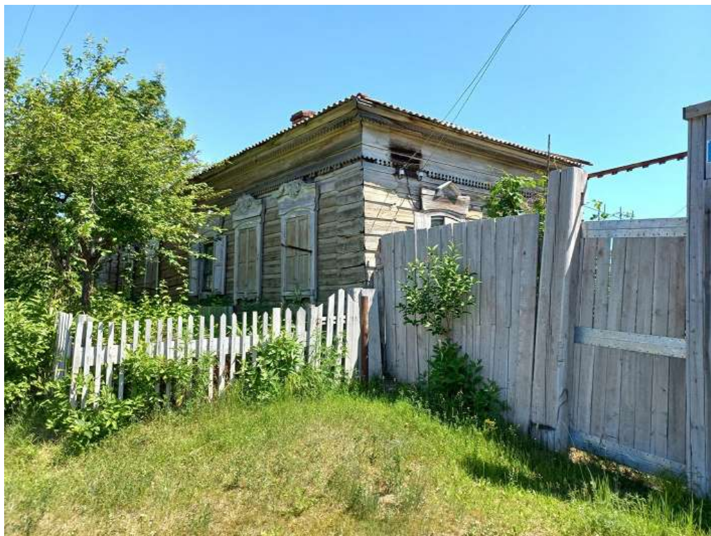
Рис. 2. Северный и западный фасады. Вид с западной стороны. Июнь 2022 г. Источник фото [1]
